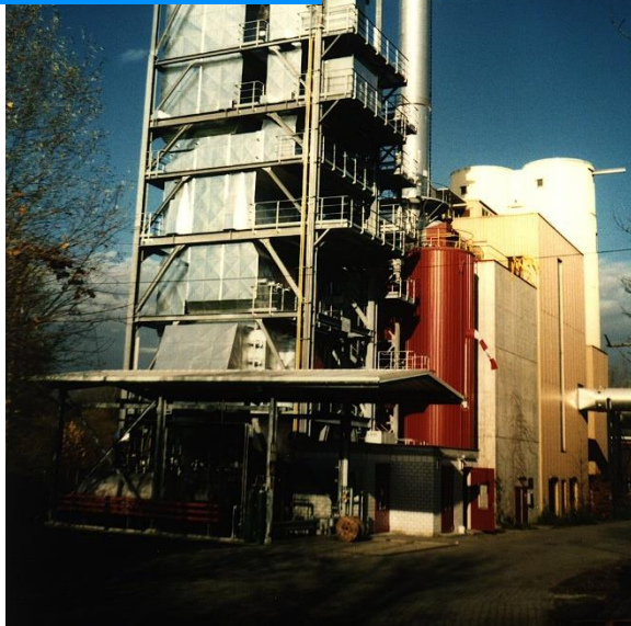
Ausführungsbeispiel der SCR-Anlage als Endstufe nach einer nassen Rauchgasreinigung
